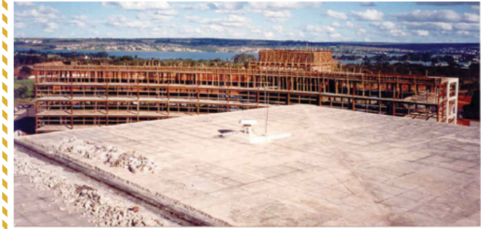
Figura 17 – Detalhe da cobertura de uma construção
