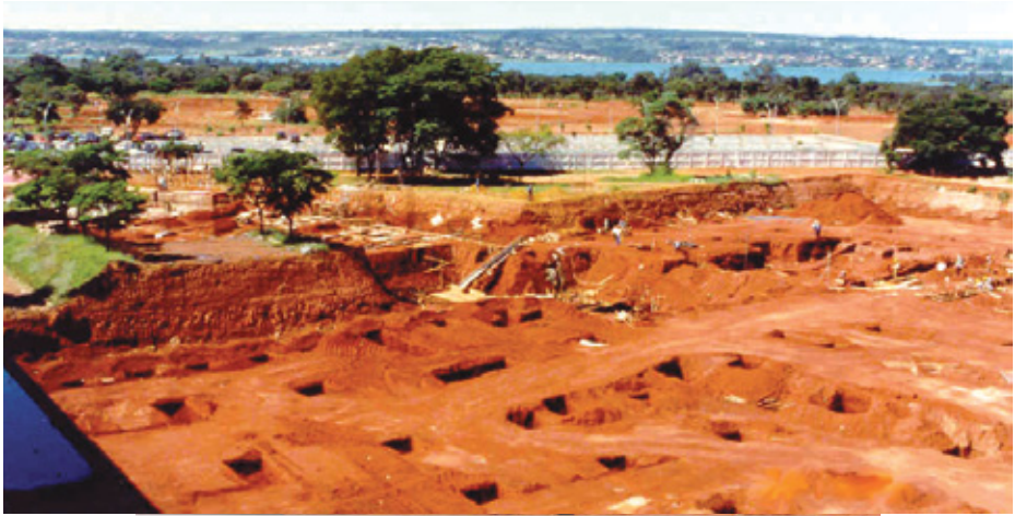
Figura 6 – Vista da localização de uma obra pública
