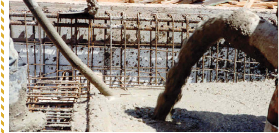
Figura 12 – Concretagem de uma laje e suas respectivas vigas
