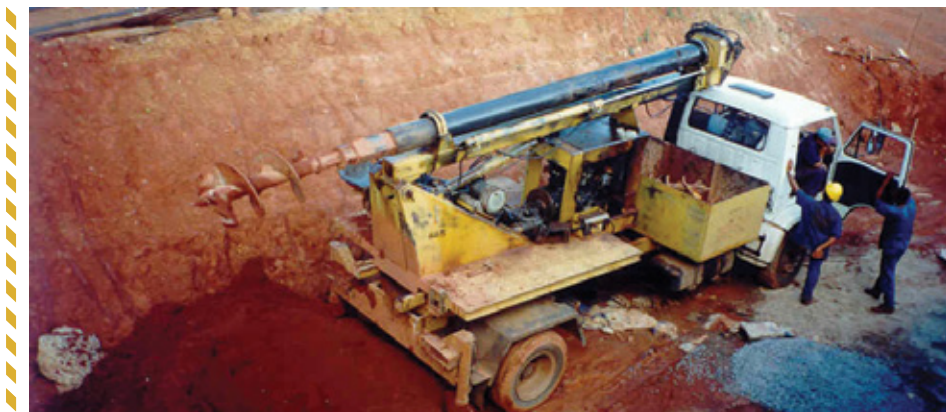
Figura 11 – Perfuração de solo para a execução de uma estaca de fundação
