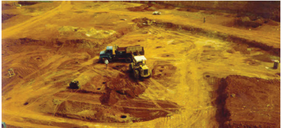
Figura 7 – Vista da execução da terraplenagem de uma futura instituição pública
